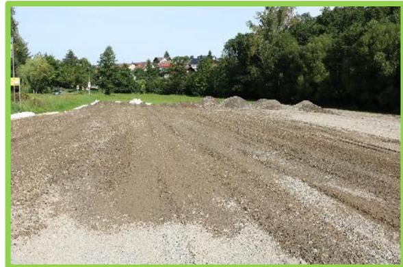
Abb. 15: Geotextil und Schotterschicht zur Vermeidung von Bodenverdichtungen (© Schnitstelle Boden)
