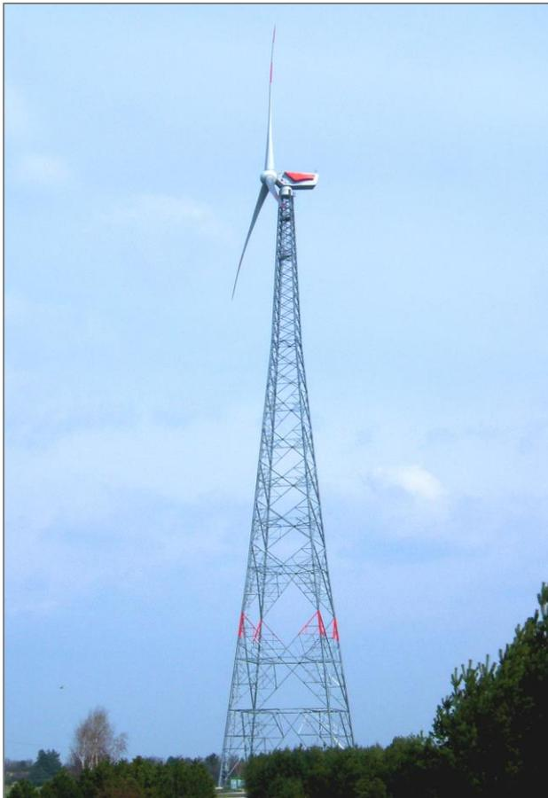
Abb. 6: Gittermastturm (© SPBer in Wikipedia, CC BY-SA 2.0, via Wikimedia Commons, [https://commons.wikimedia.org/wiki/File:Windkraftanlage\\_Laasow.jpg](https://commons.wikimedia.org/wiki/File:Windkraftanlage_Laasow.jpg))
