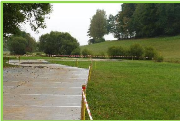
Abb. 14: Bodenschutzplatten (Lastverteilungsplatten) zur Vermeidung von Bodenverdichtungen (© Schnitstelle Boden)
