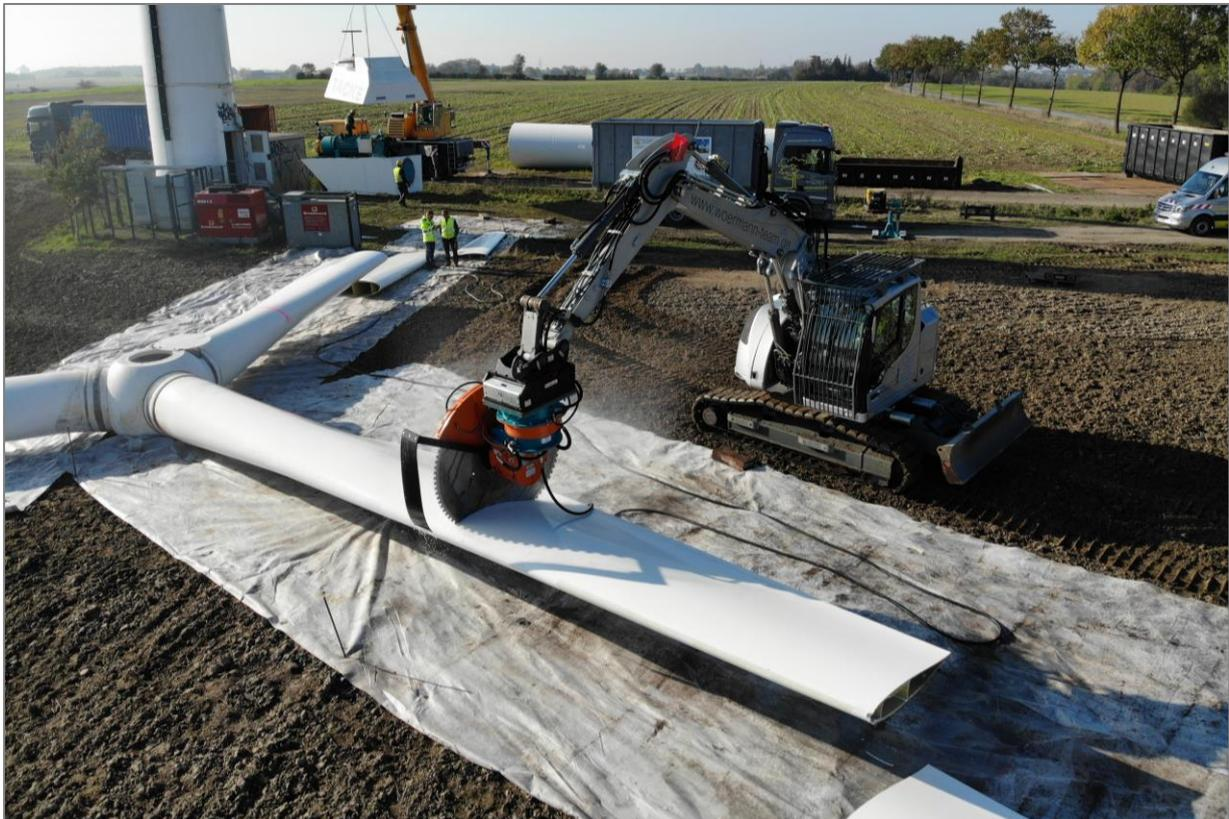
Abb. 16: Demontage eines Rotorblattes mittels Säge und Schutz des Bodens vor Staubeinträgen im unmittelbaren Umfeld durch Ausbreiten eines Geotextils (© Wörmann-Team GmbH & Co. KG, [www.woermann-team-verkehr.de](http://www.woermann-team-verkehr.de))
