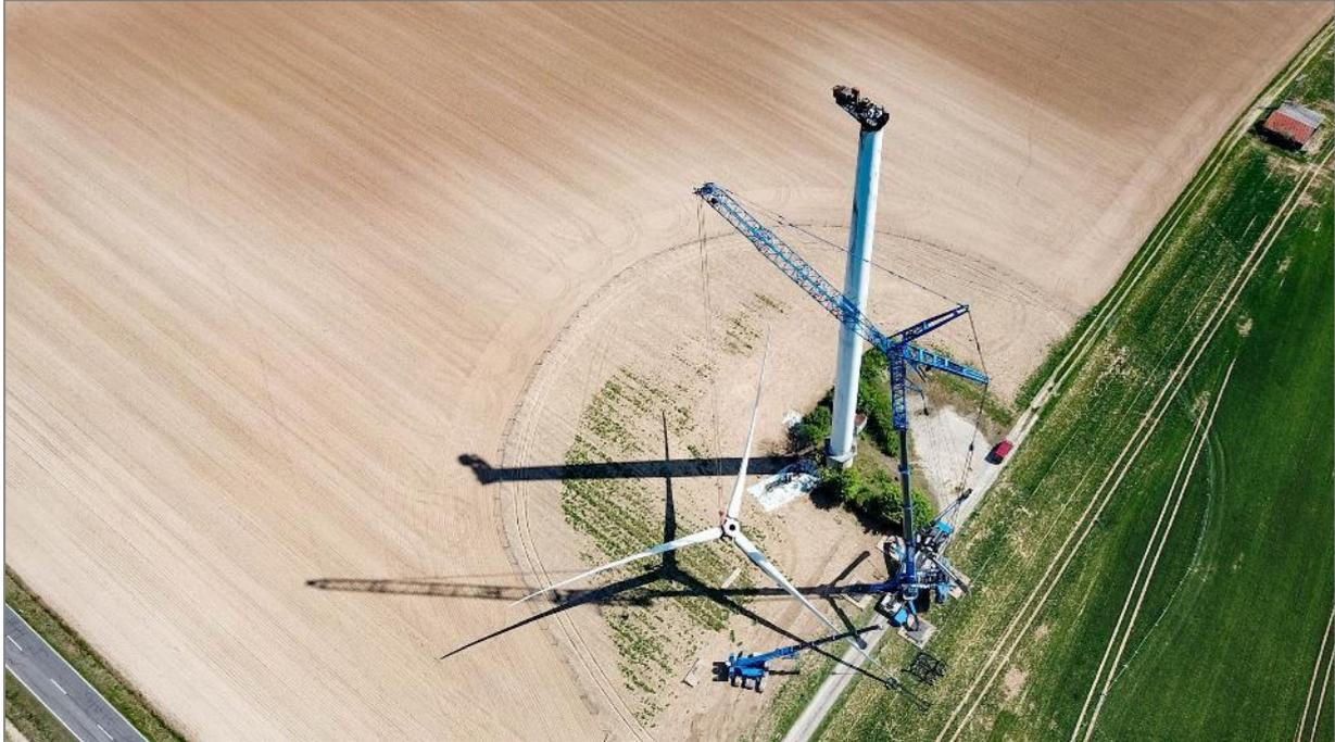
**Abb. 5: Abbau der Rotorblätter als ganzer Rotorstern (© Neowa GmbH, [www.rdrwind.de](http://www.rdrwind.de))**
