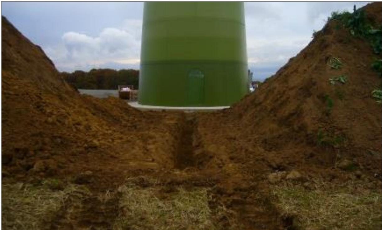
Abb. 10: Kabeltrasse einer WEA (© wind.bau GmbH & Co. KG, [www.wind-bau.de](http://www.wind-bau.de))
