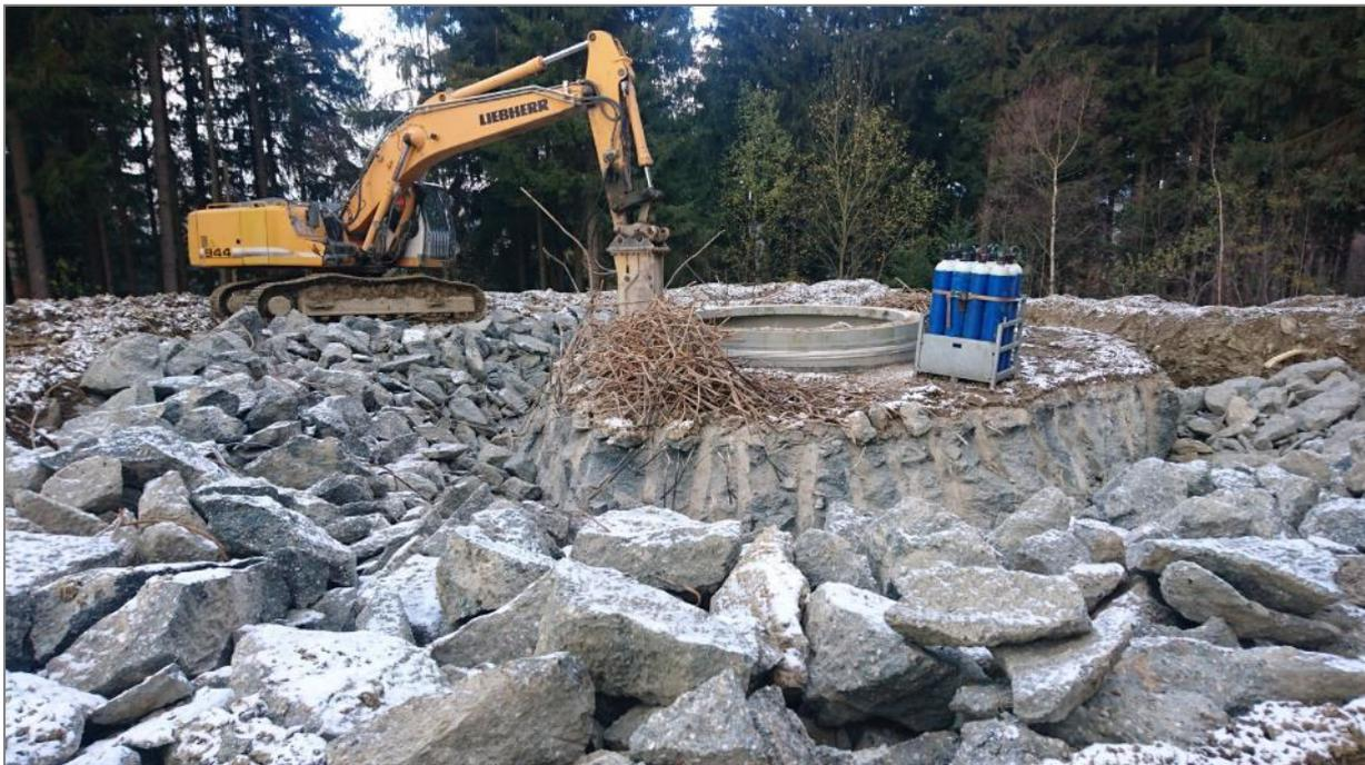
Abb. 19: Rückbau eines Flachfundaments (© wiwi consult GmbH & Co. KG, [www.wiwiconsult.de](http://www.wiwiconsult.de))
