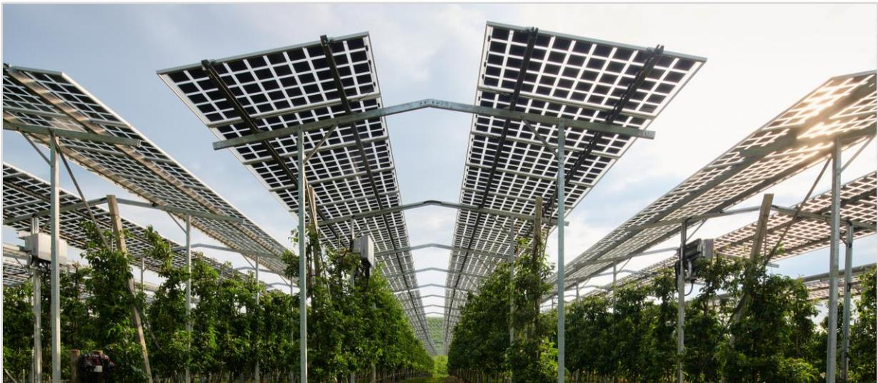
**Abbildung 13: Mit Solarmodulen überspannte Apfelbäume des Obsthofes Bernhard am Bodensee als Teil des Forschungsprojekts „Modellregion Agri-Photovoltaik Baden-Württemberg“ (Quelle: ISE Fraunhofer)**
