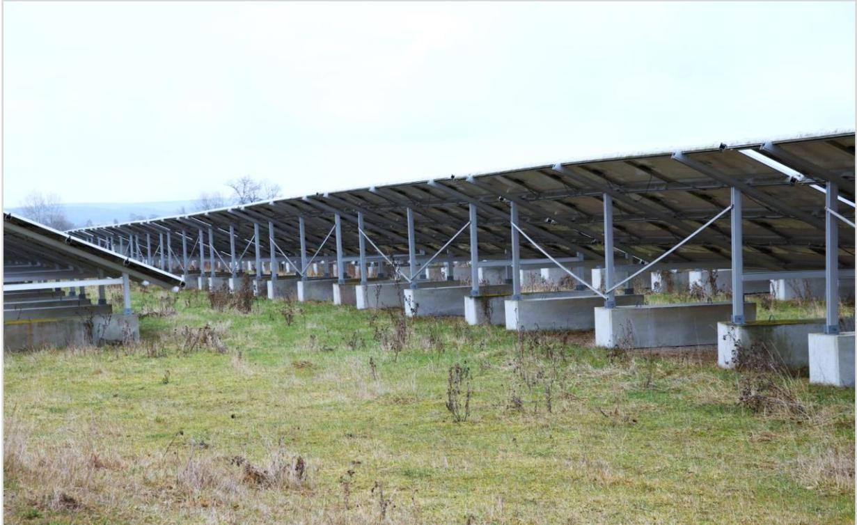
**Abbildung 7: Starre Reihenanlage – Gründung mit Betonfundamenten (schwimmend)**
