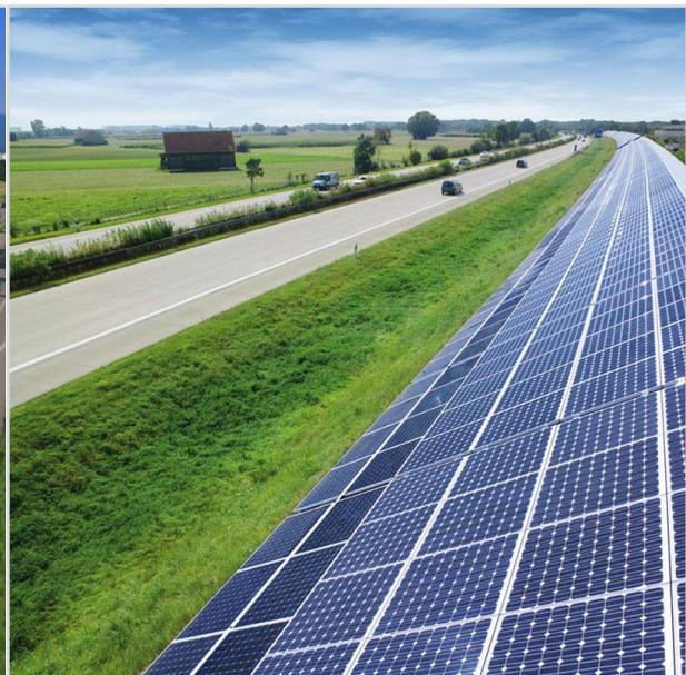
**Abbildung 17: Photovoltaik-Lärmschutzanlage entlang der A92 bei Freising (ca. 1,2 km Länge)**
