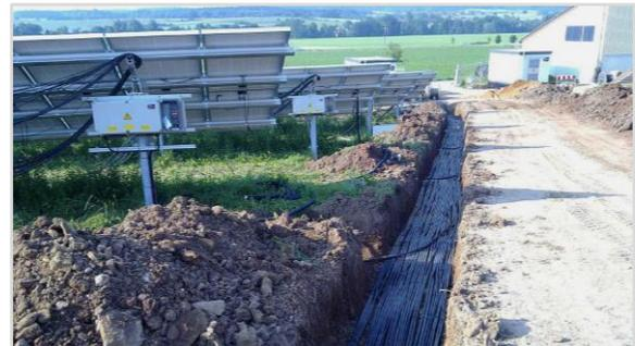
**Abbildung 36:** Erdkabeltrasse einer Photovoltaik-Freiflächenanlage (© Franke Elektrotechnik GmbH [www.solarstrom.de](http://www.solarstrom.de))
