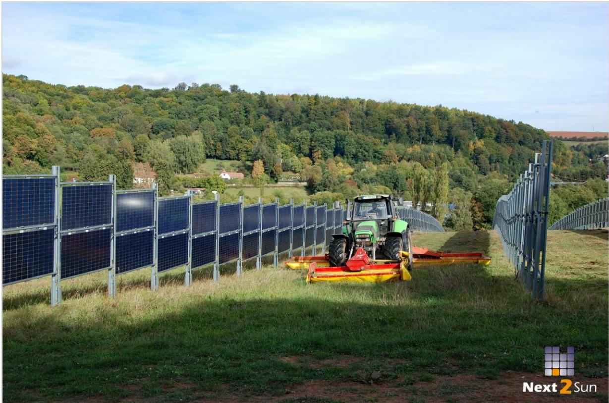
**Abbildung 20: Photovoltaik-Freiflächenanlage mit bifacialen Modulen (Solarzaun) und landwirtschaftlicher Nutzung (Quelle: [www.next2sun.de](http://www.next2sun.de), abgerufen am 19.01.2023)**
