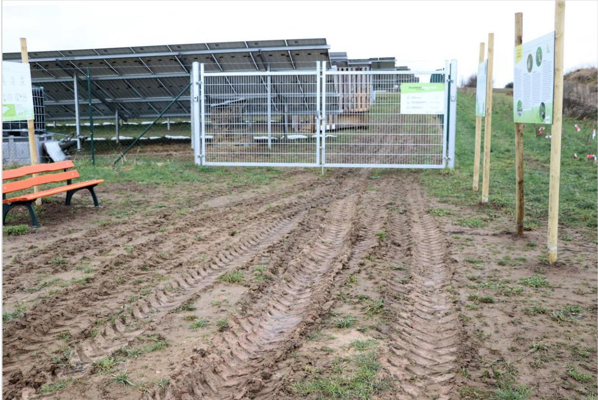
**Abbildung 26:** Einfahrtbereich einer neu errichteten PV-Freiflächenanlage mit häufigen Überfahrten sowie Befahrung mit schweren Maschinen/Radfahrzeugen und entsprechend Fahrspuren und sichtbaren Bodenverdichtungen (© Baader Konzept GmbH)
