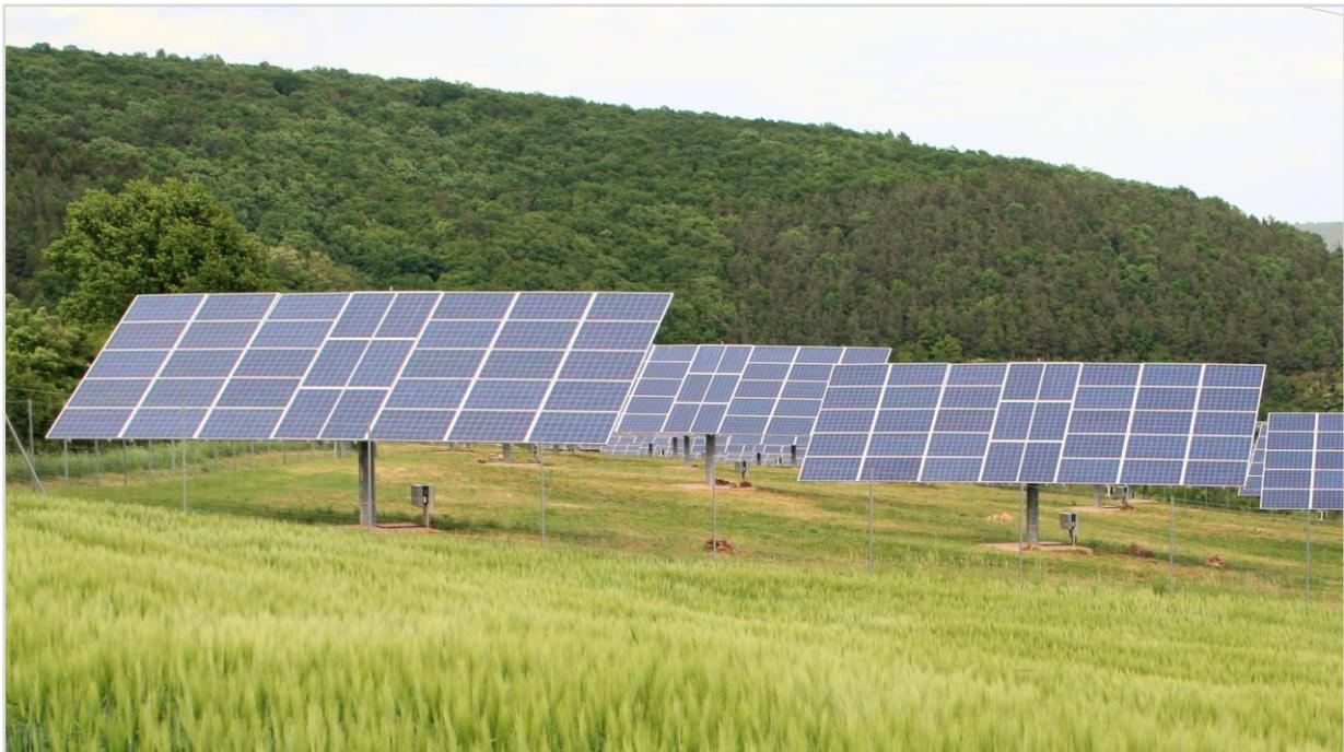
**Abbildung 39: Photovoltaik-Freiflächenanlage mit Betonfundamenten (© Schnittstelle Boden)**
