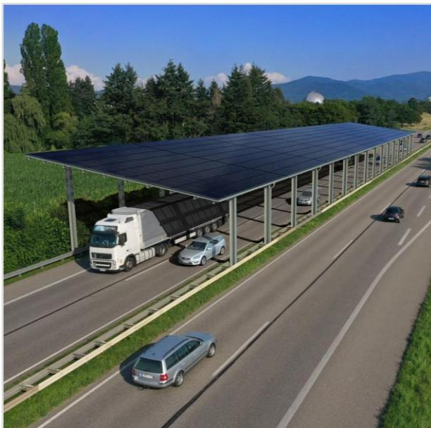
**Abbildung 16: Visualisierung einer Straßenüberdachung mit Photovoltaik**
