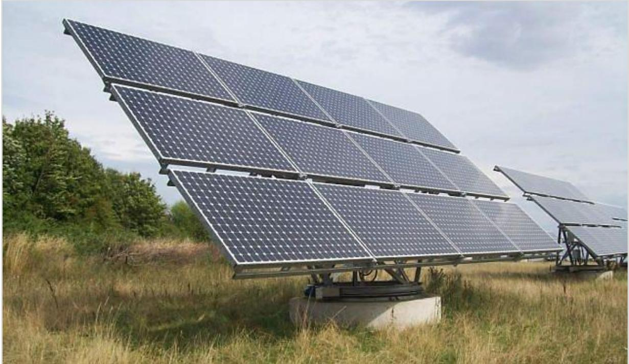
Abbildung 5: Nachgeführte Anlage (2-achsig), Gründung mit Betonfundament, weiter Stand, deutliche Modulabstände (Quelle: Photovoltaikforum GmbH [www.photovoltaikforum.com](http://www.photovoltaikforum.com), abgerufen am 18.01.2023)
