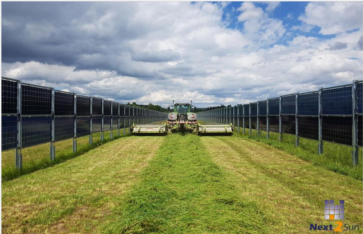
Abbildung 11: Senkrechte Aufstellung **bifacialer Module** in Ost-West-Ausrichtung – Form der Agri-Photovoltaik (Quelle: [www.next2sun.de](http://www.next2sun.de), abgerufen am 19.01.2023)
