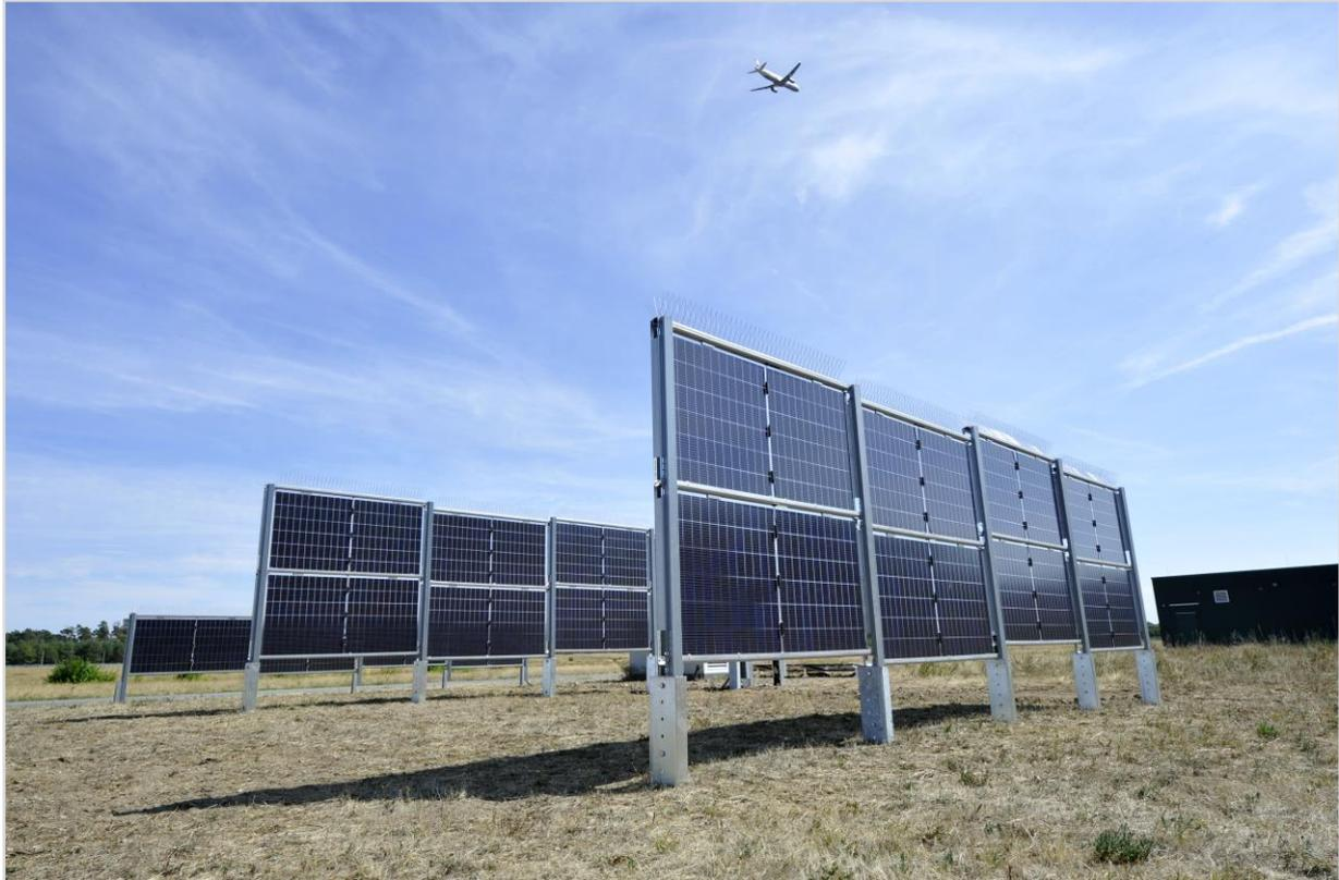
Abbildung 19: Pilotanlage mit **bifacialen Modulen** am Flughafen Frankfurt (© Fraport AG)
