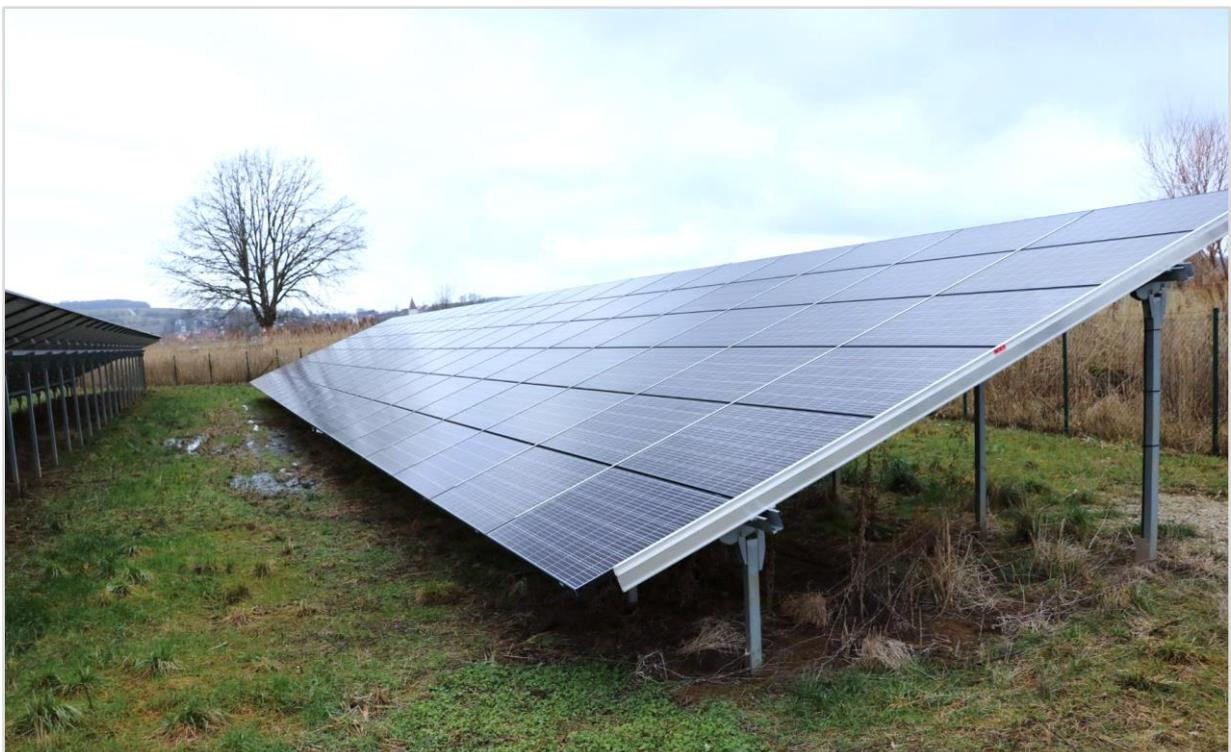
**Abbildung 8: Starre Reihenanlage – Gründung mit Rammpfählen aus verzinktem Stahl**
